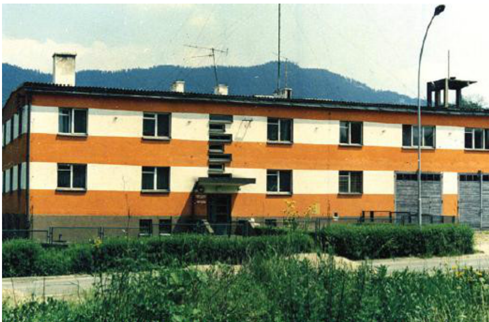
Rys. 1 Budeynek ZSP Limanowa wybudowany w latach 60.
