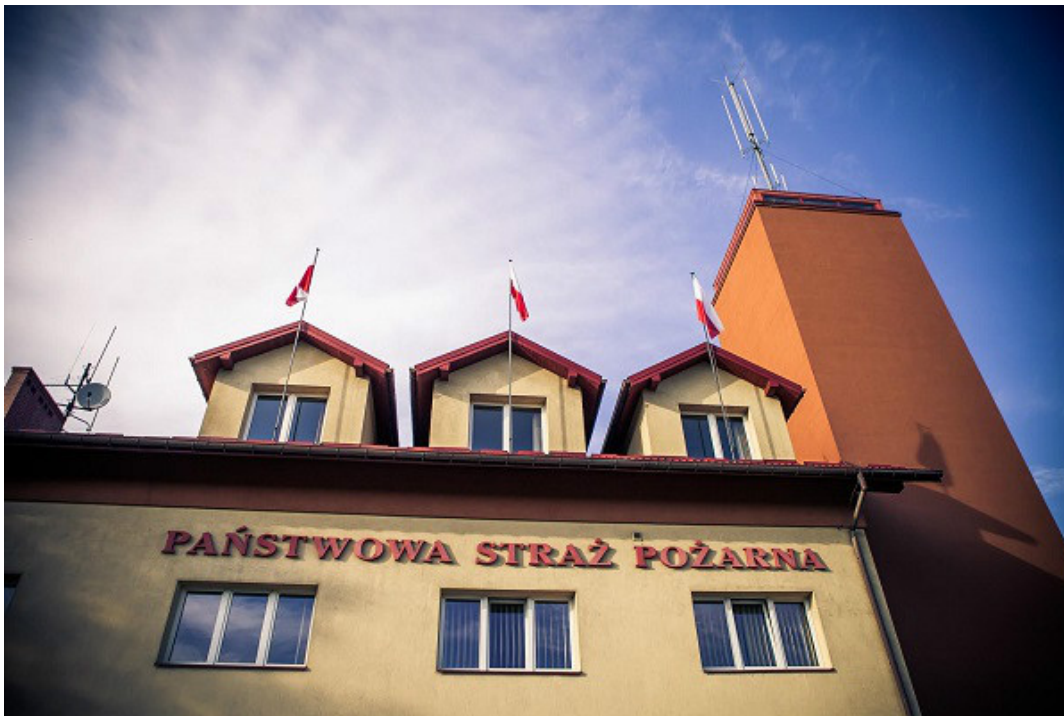
Rys. 4 Budynek KP PSP Limanowa 2015r.
